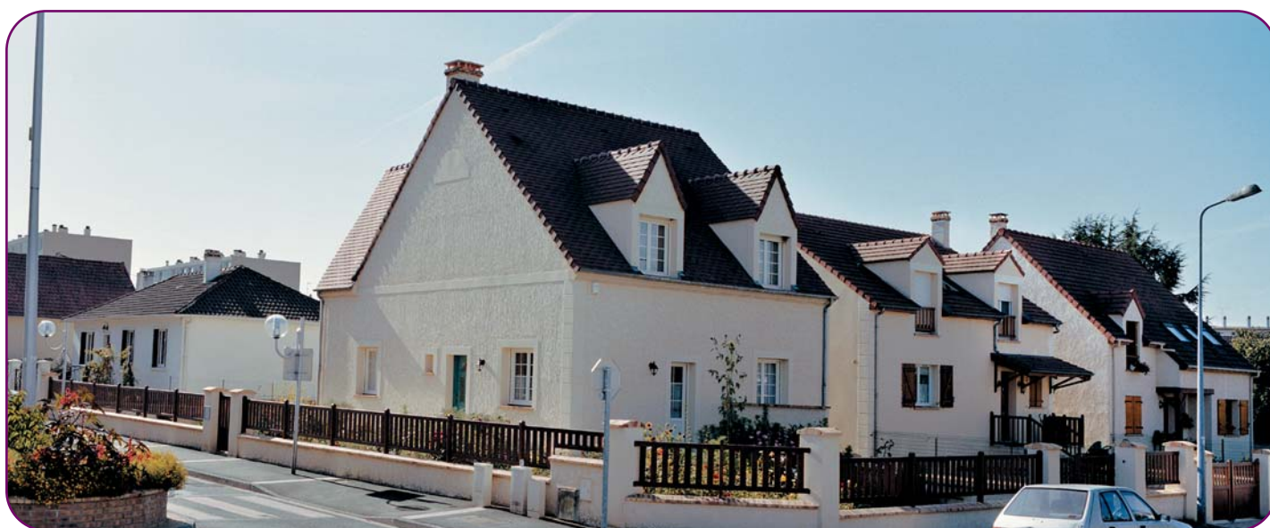
Maison de 141 m 2 construite en 2000 en Ile de France, équipée d'une pompe à chaleur air/eau alimentant un plancher chauffant rafraîchissant
